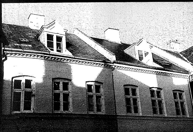
Langt de fleste byhuse var før år 1800 stråtekte, men de mange brandkatastrofer var medvirkende til, at der blev indført krav om „stentage“. Skifer er et særligt anvendt materiale på offentlige bygninger, jernbanestationer, posthuse, skoler, men også en del beboelseshuse får den sortgrå naturskifer, deriblandt byggeforeningshusene på Olufsvej.
